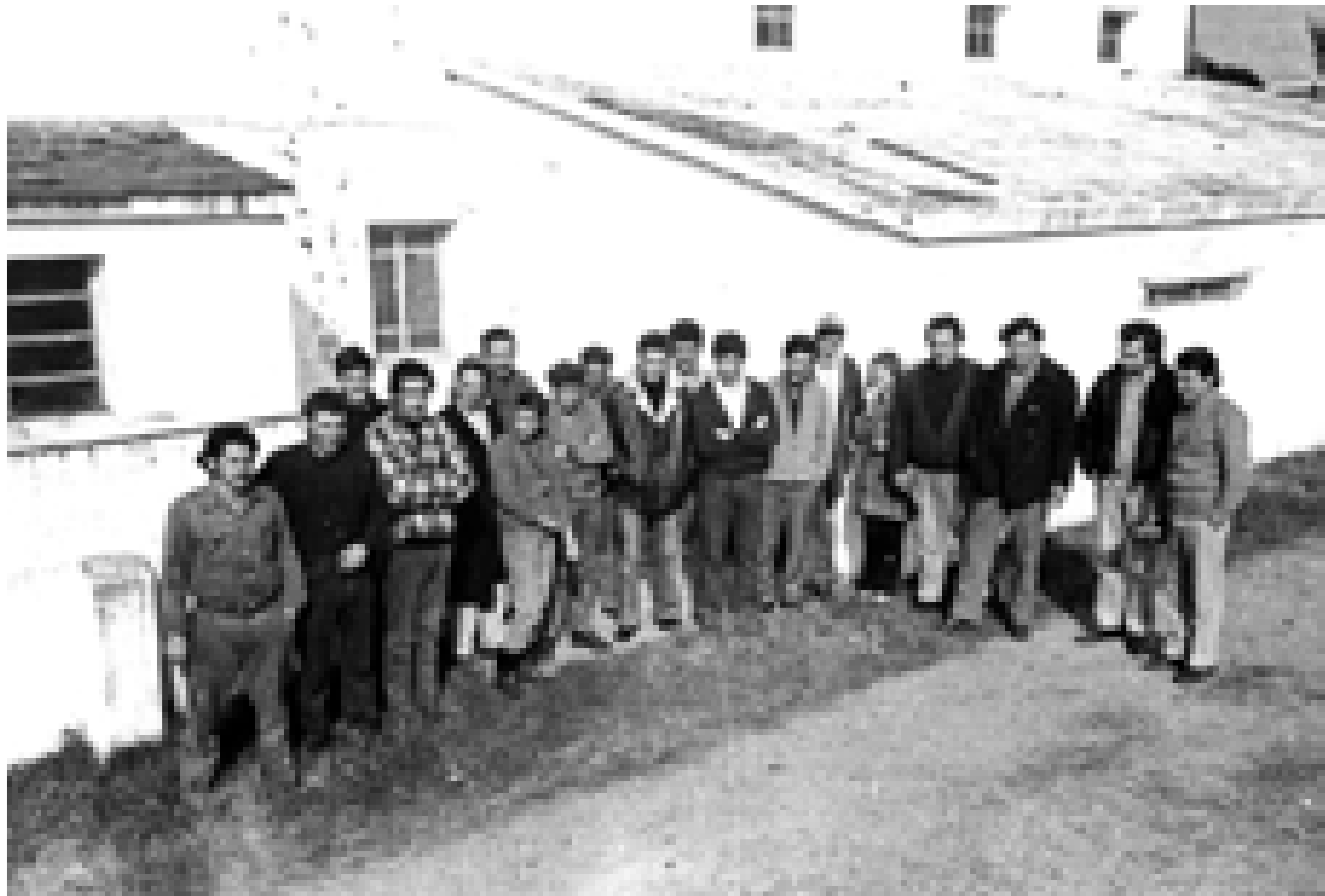
Obreros ocupantes de una curtiembre, durante la huelga general. 27 de junio-11 de julio de 1973. (Foto: 140– Autor: Aurelio González).
